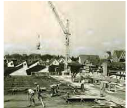
Neubau der Einzeladerabteilung
