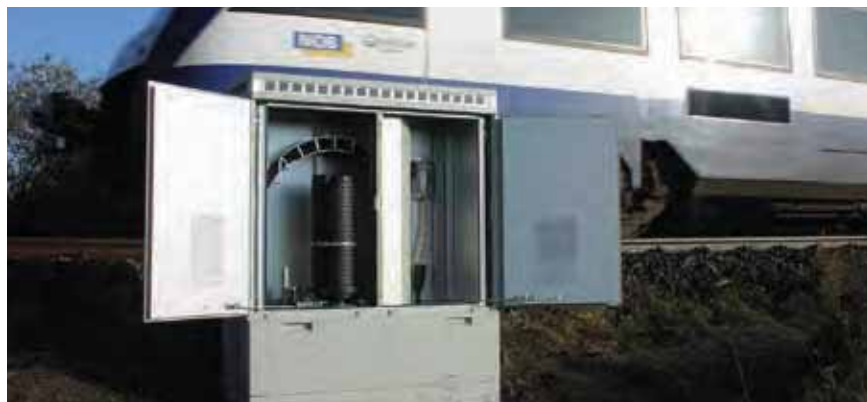
Testsieger RailOptic SFK LWL-Schienenfußkabel der Bayka bei der Deutschen Bahn AG
