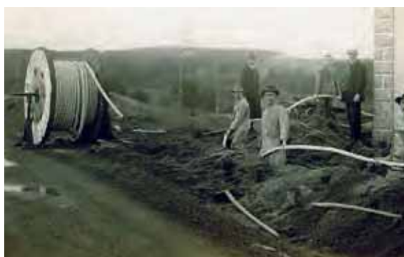
Kabelverlegung um 1930
